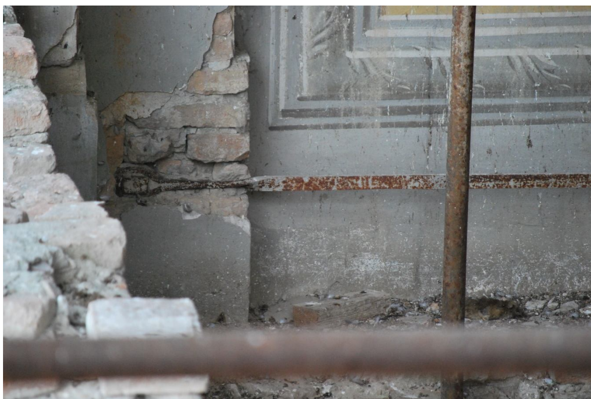
Ancoraggio della catena nel primo arco a ridosso della facciata sul lato sinistro della navata.
