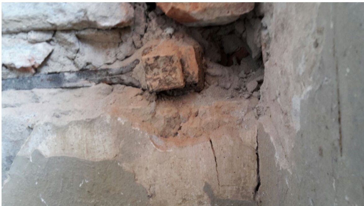
Ancoraggio della catena nel primo arco a ridosso della facciata sul lato destro della navata.
