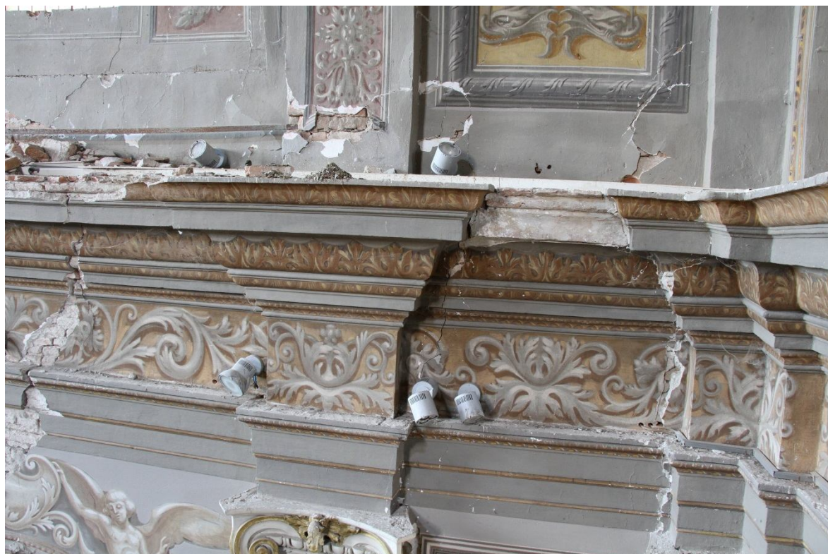
Ancoraggio della catena nel primo arco a ridosso verso l'arco trionfale sul lato sinistro della navata.
