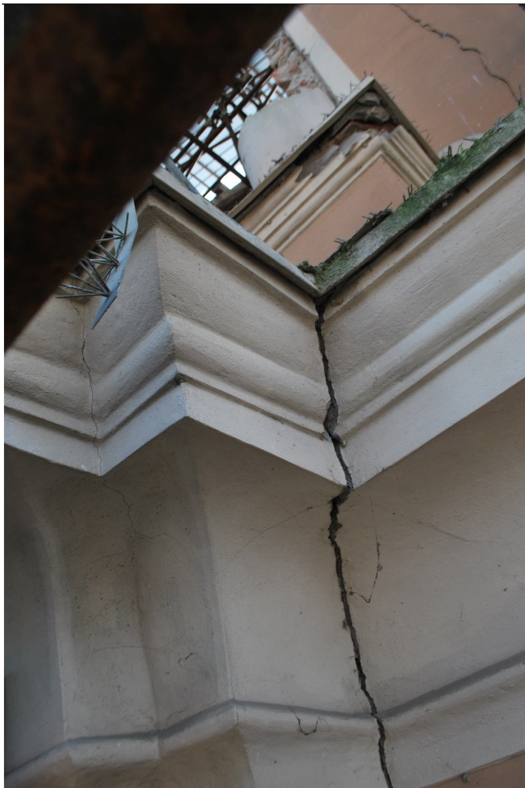
Fessura denotante il distacco tra elementi murari verticali di facciata. Cornice a 11,00m circa, lato destro facciata.
